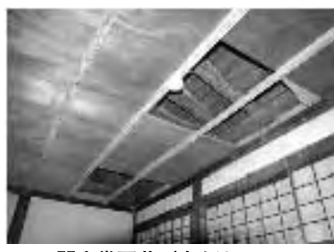
開山堂天井/穴あり天井板はコンパネ合板
