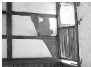
三尺坊と開山堂の繋ぎ目、裏から
