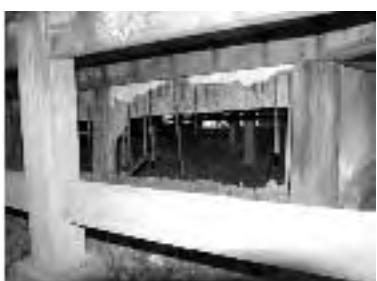
三尺坊床下/ボロボロ刺すと芯まで腐っている
